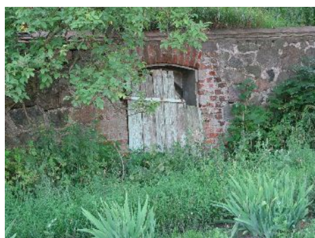
Ilustracja 5: Pomieszczenie lodowni obok dworku przy wjeździe od strony drogi
